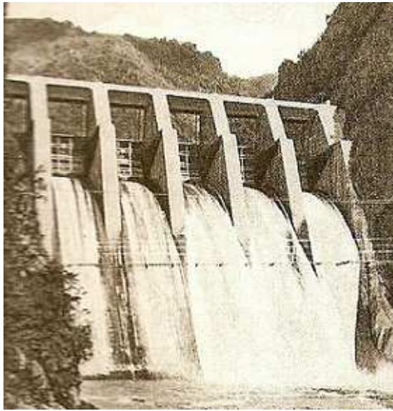
日月潭水力發電廠
