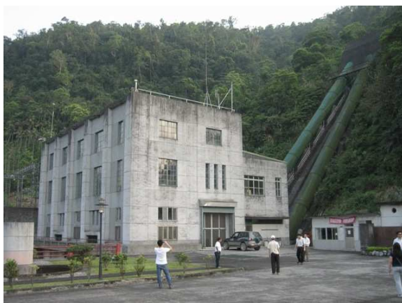
天送埤發電廠
